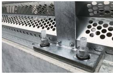
壁高欄の飛雪防止欄の支柱定着部アンカーボルトの防錆対策
