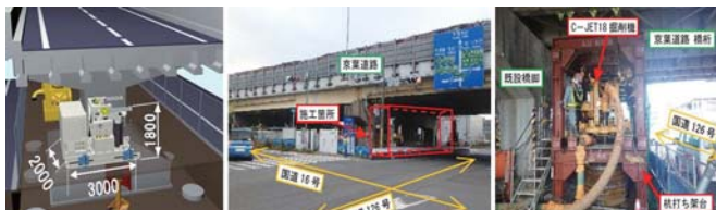
橋桁下での施工
