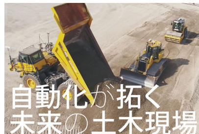
A 4 CSEL®稼働状況
