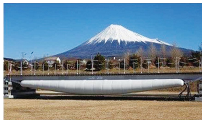
PS-Bridge®(橋長15.6m、幅員3.6m)
