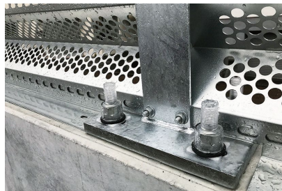
壁高欄の飛雪防止柵の支柱定着部アンカーボルトの防錆対策
