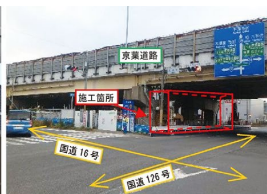
施工箇所外観
