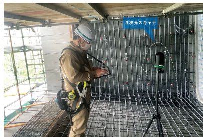
3次元スキャナによる計測状況
