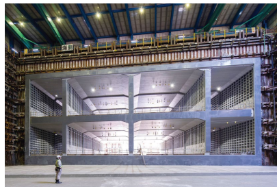
外環自動車道京成菅野アンダーパス工事 (R&C工法)
