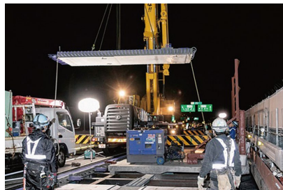
北陸自動車道高瀬橋床版取替工事
