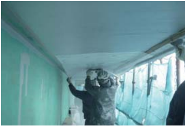
ボンド KEEPメンテ工法 VM-3 施工状況
