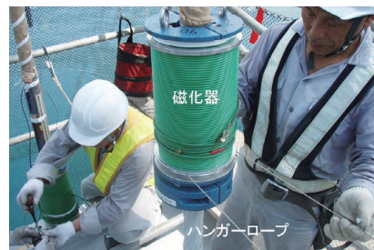
全磁束法によるケーブル内部の非破壊検査
