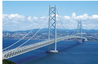
明石海峡大橋
