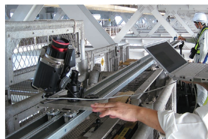
赤外線サーモグラフィによる亀裂調査
