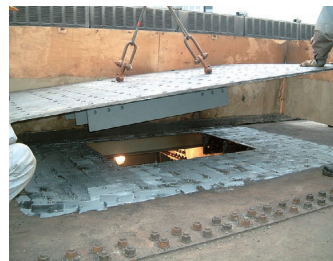
鋼構造用接着剤ボンド E258 施工状況
