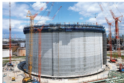
スリップフォーム工法によるLNGタンクPC防液堤構築状況
