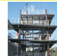
津波避難施設(SGタワー)
