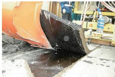
IH(電磁誘導)にて鋼床版を加熱しアスファルトを静かに剥がす
