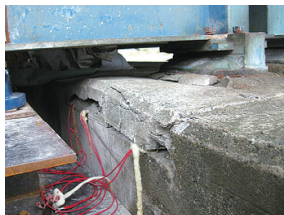
狭隘部での制御破碎
