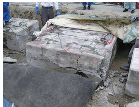
市街地での基礎解体
