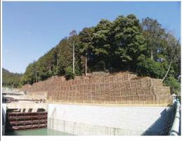
琵琶湖の南側に位置する石山寺で行なわれた大津放水路事業 石山寺の景観保全のため、施工されたコンクリート吹付けをはぎ 取って施工したケース。 [滋賀県大津市 2005年施工]
