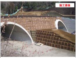
圏央道八王子ジャンクションのトンネル坑口に施工された事例。 斜面の安定確保はもちろん、間伐材の独特の風合いが周囲の山々の景観と調和している。 [東京都八王子市 2005年施工]
