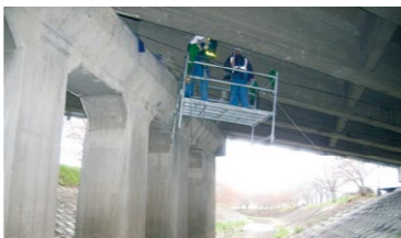
橋梁点検にワイヤーワークを活用した事例
