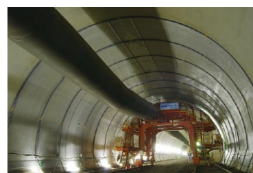
トンネル工事における施工状況
