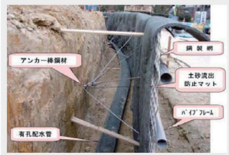
↑ 水のかたで壊れたコンクリート ← 全天候フォレストベンチのしくみ
