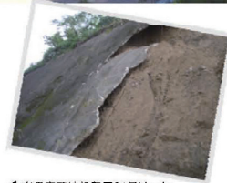
↑ 水のかたで壊れたコンクリート ← 全天候フォレストベンチのしくみ
