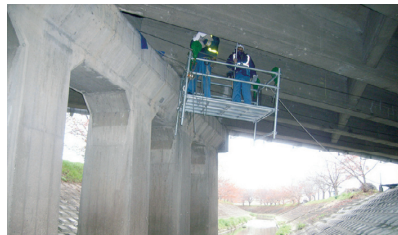
橋梁点検にワイヤーウォークを活用した事例
