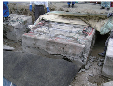
市中での基礎解体
