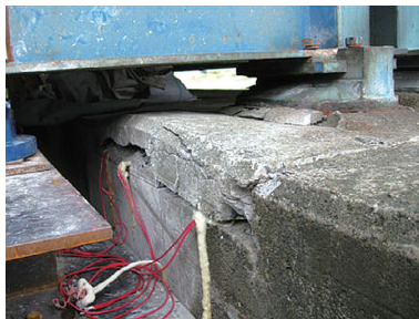
狭隘部での制御破碎
