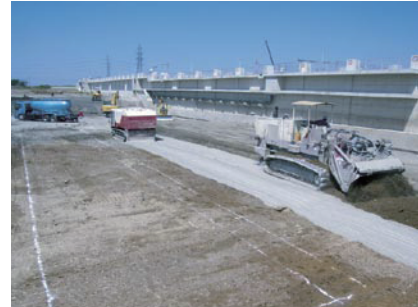
STB360C (1.2) 施工状況
