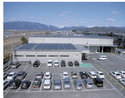
(株)東洋スタビ 本社 事務所
