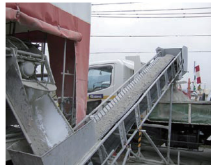
モイストセメント製造状況
